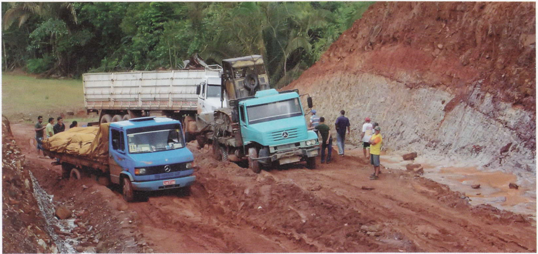
▲ Асфальт предполагалось укладывать прямо на укатанную насыпь
